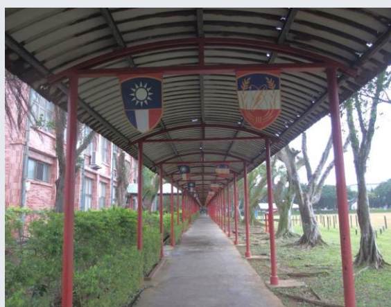
風雨走廊現況
