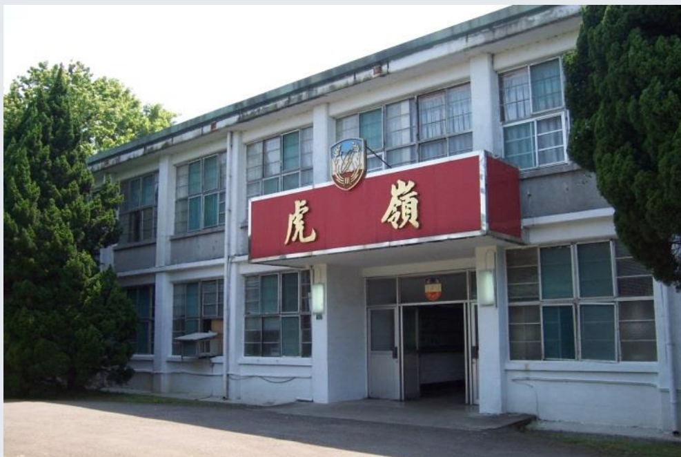
行政大樓現況
